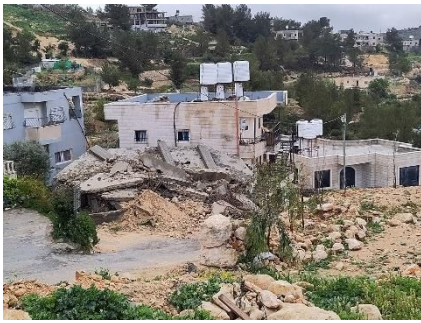
Zerstörte Häuser, Bild 43 WGT DVD
