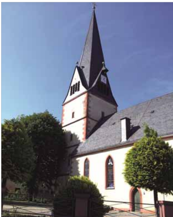
Die evangelische Kirche in Echzell wurde auf den Grundmauern einer römische Badeanlage errichtet. Foto: S. Puchert
